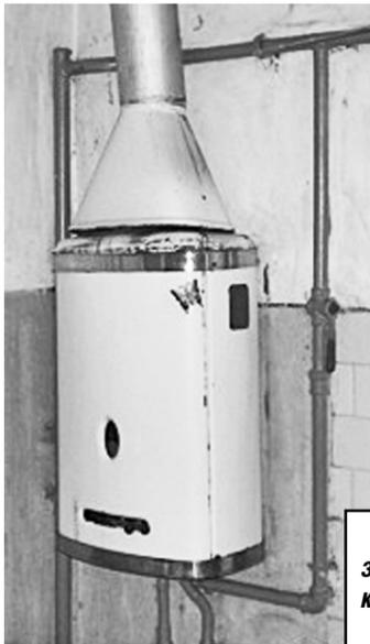
приборами, из-за отсутствия притока воздуха во время их работы. Во время ЧП элементарно не было естественной приточно-вытяжной вентиляции, которую обеспечивает приткрытая форточка. В результате
